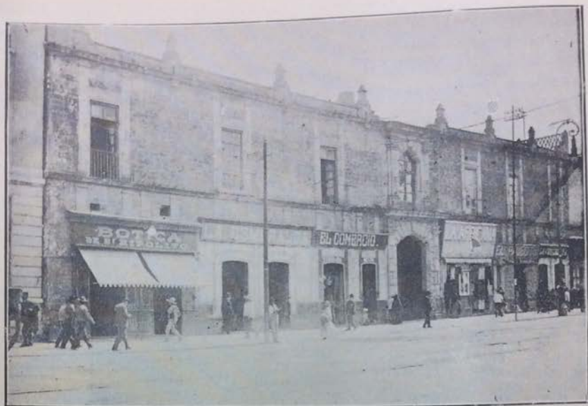
Fachada del antiguo Hospital de San Hipólito, convertido en la actualidad en casa de departamentos.
