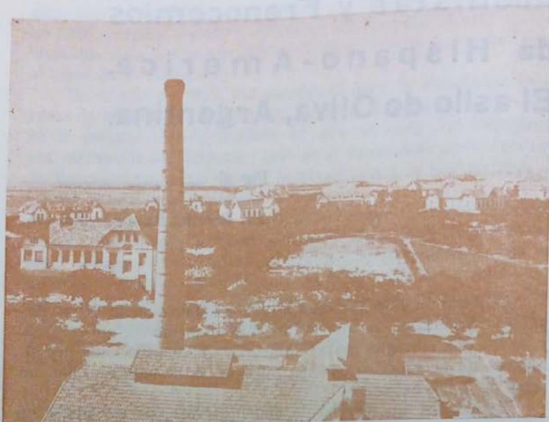
Conjunto de pabellones
