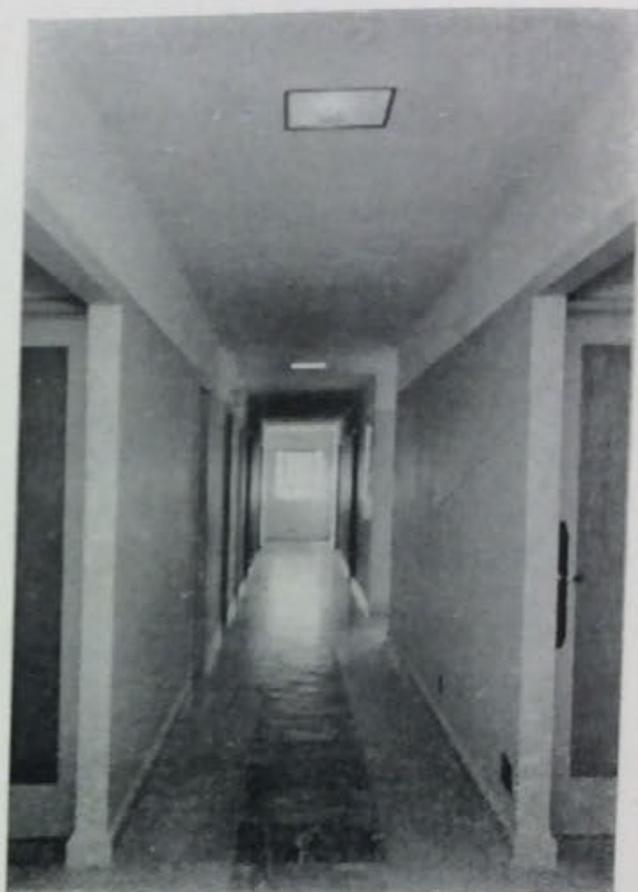
Pasillo del segundo piso.
